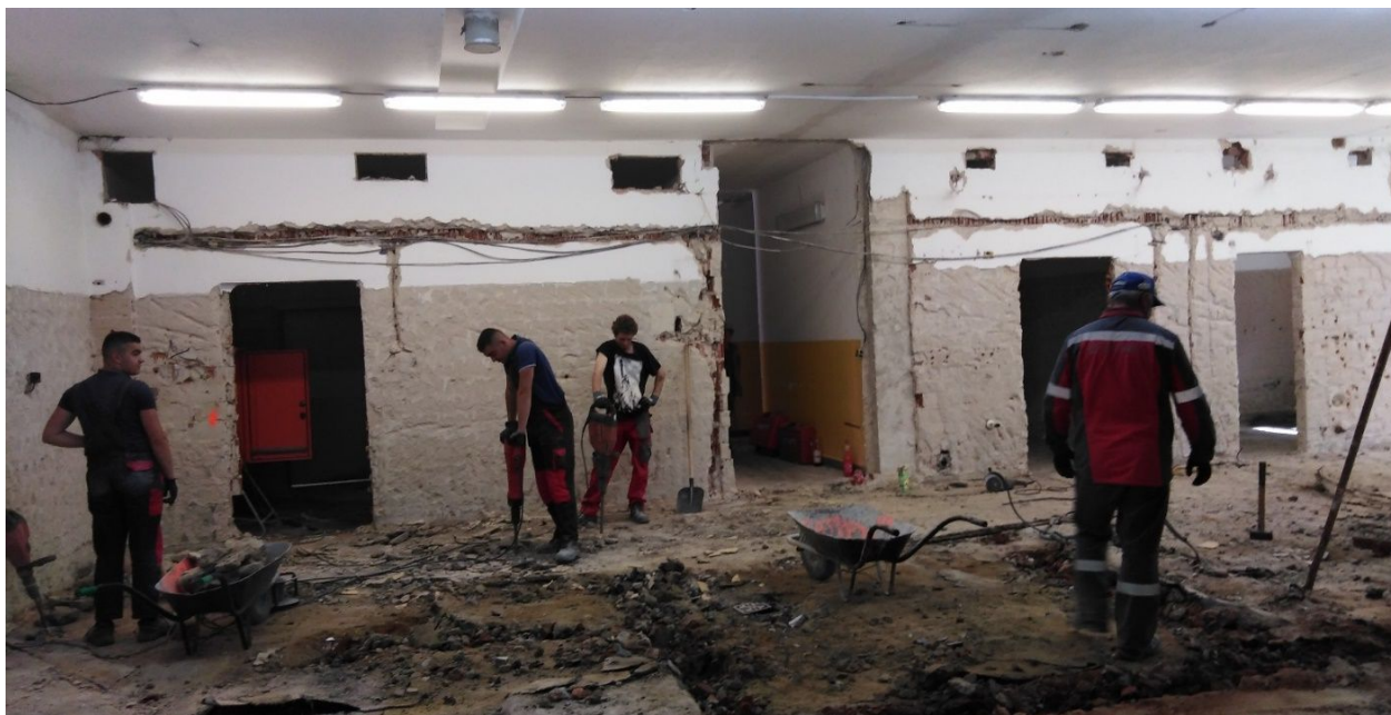
Dělníci rozvrtávají podlahu
